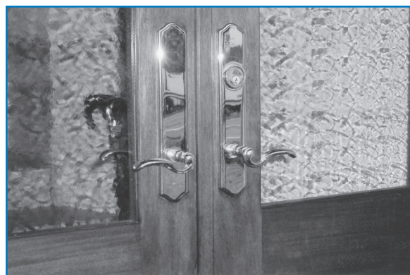
FIGUUR 3-14 Kleur (messing) was de belangrijkste fysische eigenschap bij de keuze van een materiaal voor dit decoratieve deurbeslag
